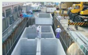
■ 川崎食品産業株式会社 排水処理設備工事風景 40m 3 ユニット槽×7槽
